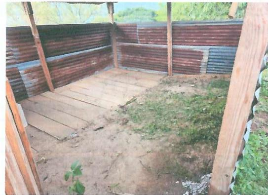
Foto 4: El piso de la cocina una parte de madera y la otra parte es de tierra, por lo que es necesario mejorarlo.
