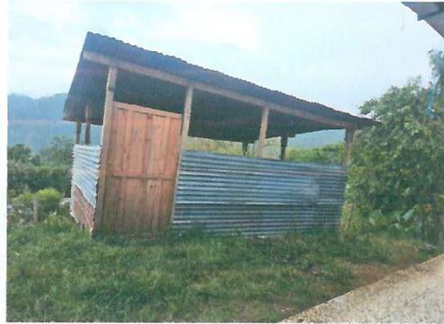
Foto 2: El cambio de techo es necesario debido que las láminas ya están oxidadas, así como también su estructura es de madera.
