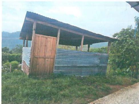
Foto 3: La instalación de la puerta es necesario, la que tiene la cocina está deteriorada.
